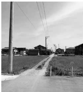
▲整備計画区間の未舗装道路（道林町、浜町地内）
